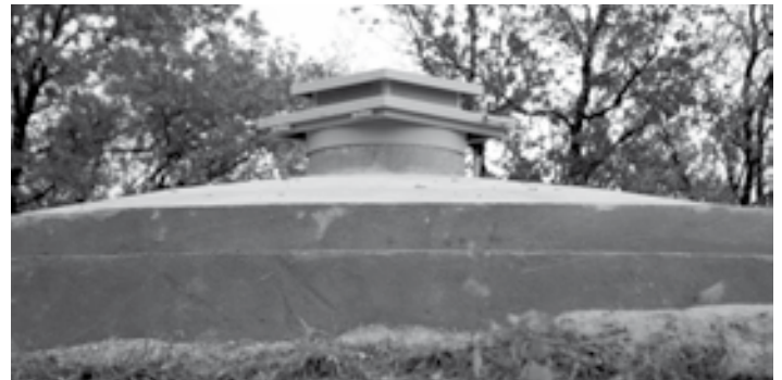
Le château d'eau de Galeye après les travaux d'étanchéité sur le dôme.
