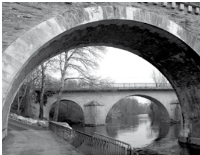
Vu de l'arche du pont ferrovière, le pont de Navès qui, sous son tablier moderne, repose encore sur un bel ensemble de piles et d'arches de pierre.
