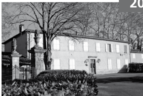
Le site de Lostange accueille l'APAJH depuis 2010
