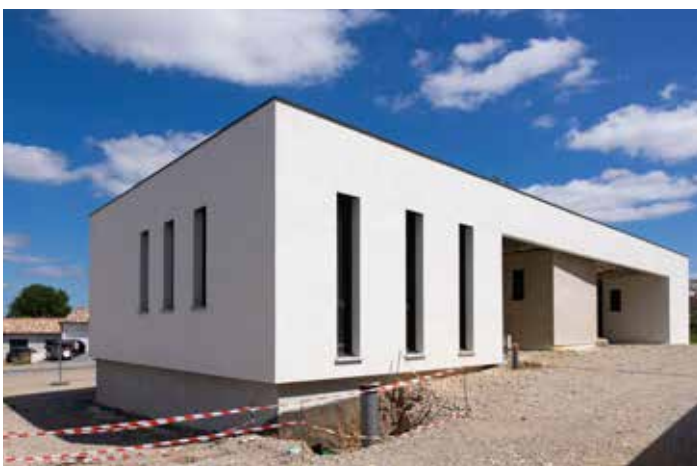
Un bâtiment d'allure moderne dont l'intérieur sera très fonctionnel.
