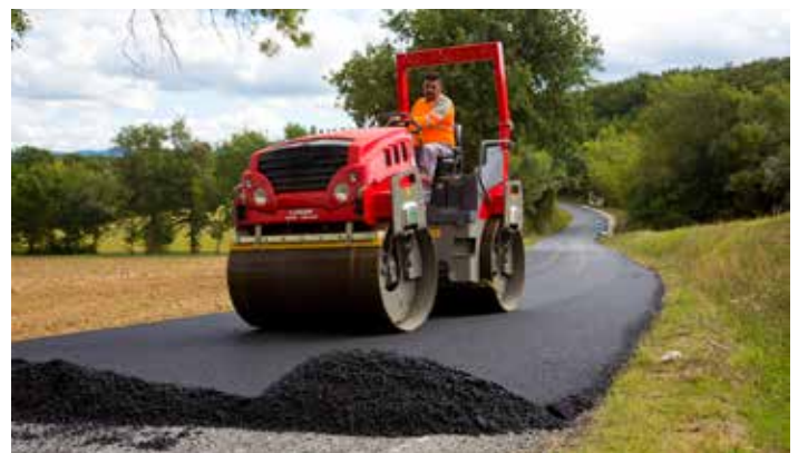
Elargissement du chemin des Garosses (VC1) et pose d'un nouvel enrobé en 2016-2017.
