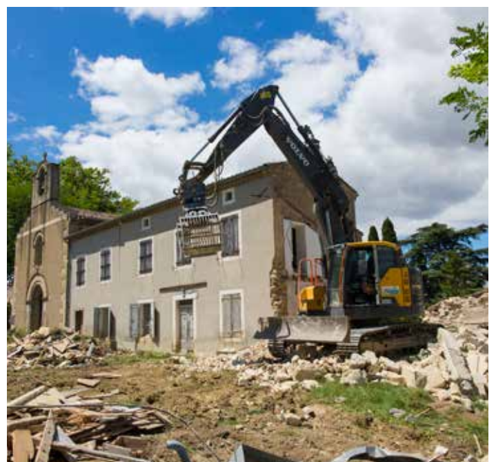
Les premiers coups de pelle lors de la destruction du presbytère.
