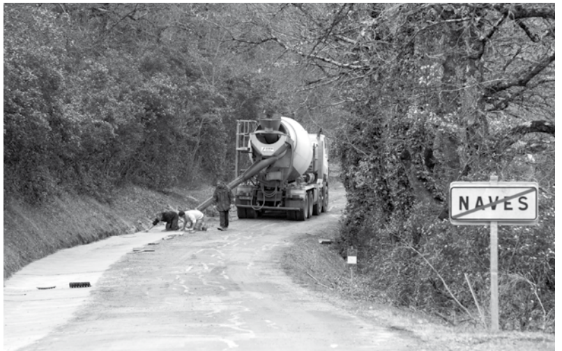
Les récents travaux sur la VC1 ont été co-financés par le Département.
